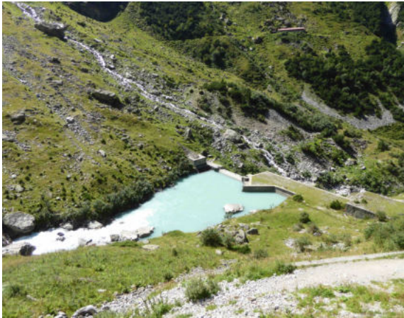
Abb. 10: bestehende Wasserfassung bei der Bergstation KWO-Bahn (93)
